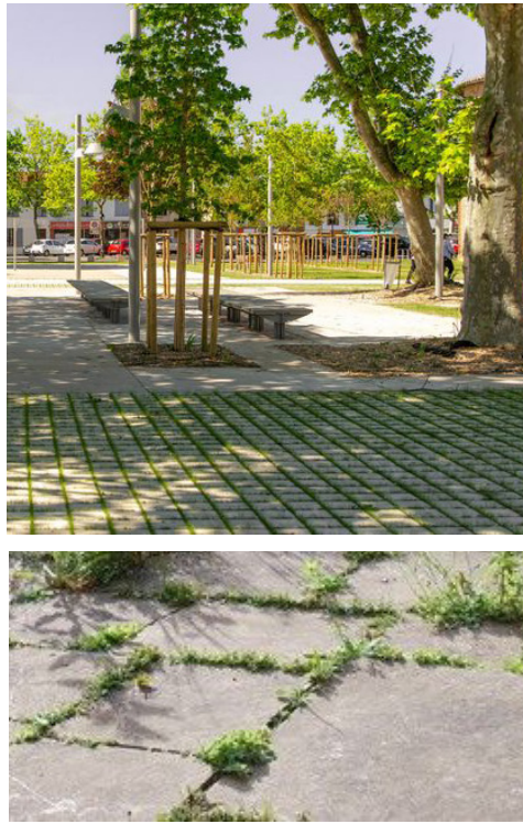
PROMENADE DIGUES Dalles béton joints drainants
